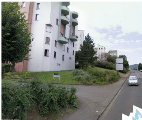
Immeubles collectifs en retrait des voies à Beaumont
